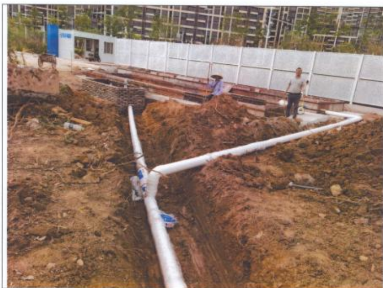
临时排水措施和沉砂池图片
