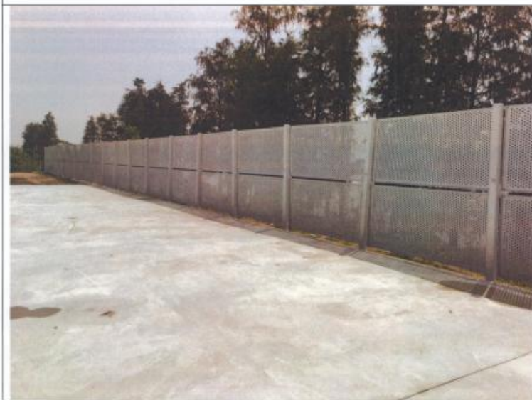
临时性围墙图片
